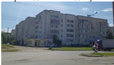
Рисунок 1 – Расположение объекта по ул. К. Либкнехта, 83
