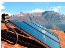
Плоский солнечный коллектор MFK001 с рабочей площадью 2,3\text{м}^2
