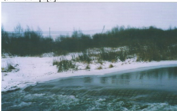
Рис. 1. Переливная плотна на рыбоходно-нерестовом канале
