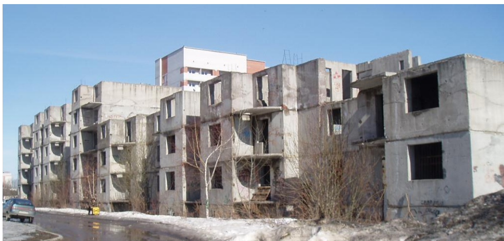
Общий вид обследуемого объекта – недостроенного жилого дома
