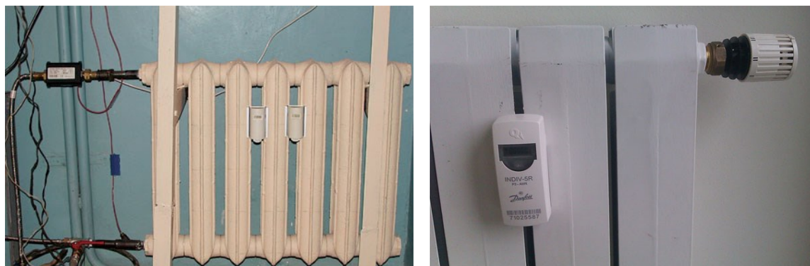
Рис. 2. Распределители стоимости тепловой энергии, установленные на отопительных приборах
