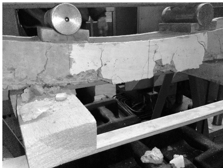
Рисунок 4 – Разрушение испытанной балки
