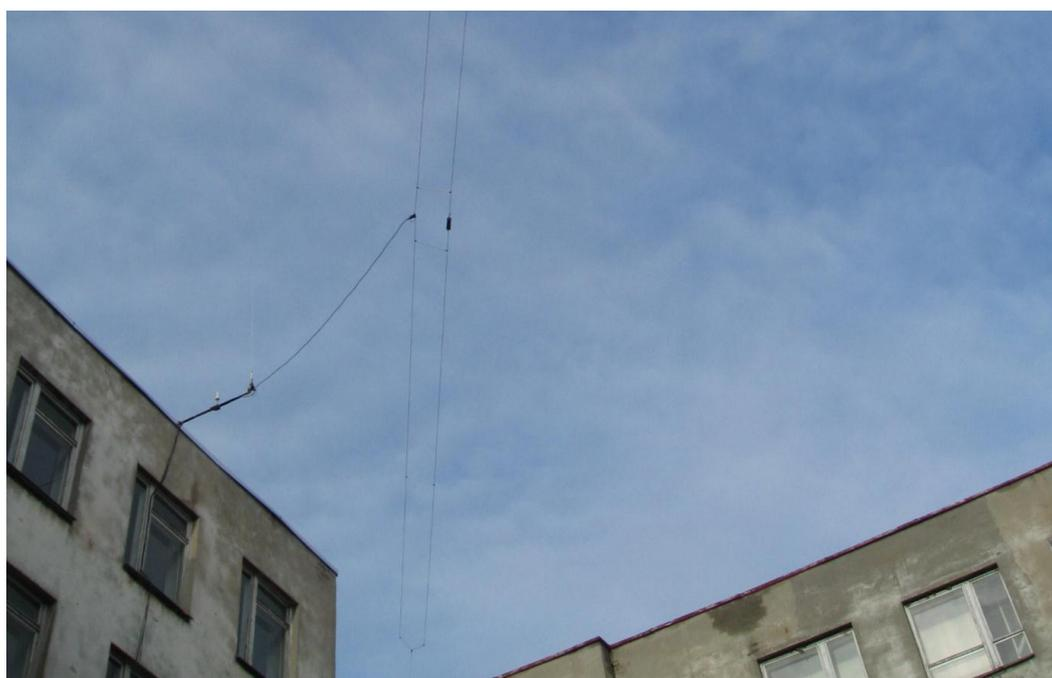
Рис. 2. Антенна типа T2FD фирмы IcomАН-710
