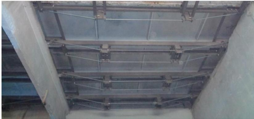
**Рис. 1. Усиление железобетонных ребристых плит покрытия разгружающими металлическими шпренгельными балками**
