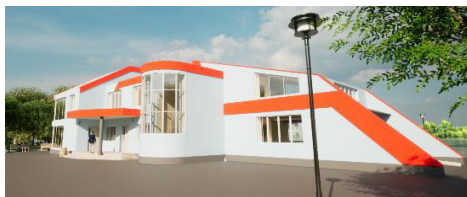
Рис. 2. Вид на водно-спасательную станцию со стороны города
