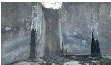
Рис.2. Ковшовый оголовок водосброса
