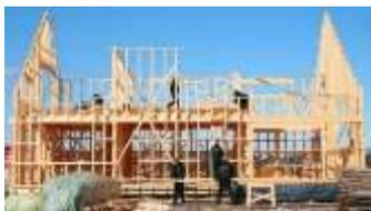
Рис. 1. Деревянный каркас многоэтажных зданий
