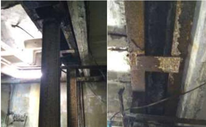
Рис. 1. Поврежденные коррозией колонны
