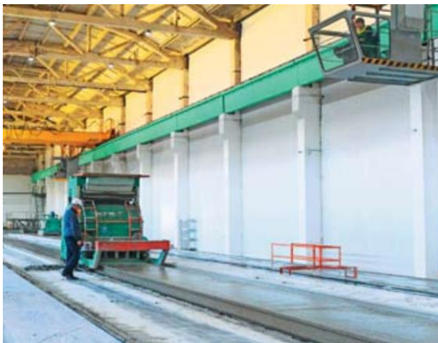
Виброформование плиты перекрытия
