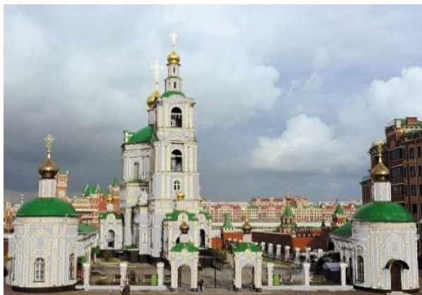
Рис. 2. Вид на западный фасад с ул. Вознесенской после реконструкции
