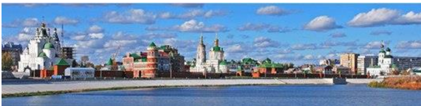
Рис. 1. Панорама набережной после реконструкции
