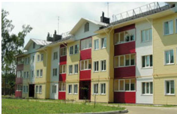
Трехэтажное здание с каркасом из ЛСТК по адресу: г. Йошкар-Ола, ул. Машиностроителей, д. 112
