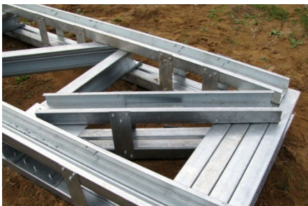
Рис. 1. Конструкция бесфасоночного узла фермы с креплением на самонарезающих винтах
